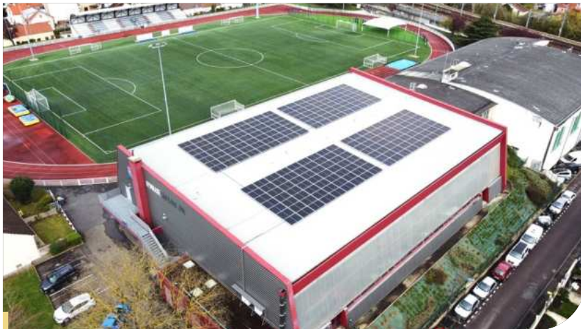
Panneaux solaires photovoltaïques sur la toiture du gymnase Léo Lagrange à Chaville.
