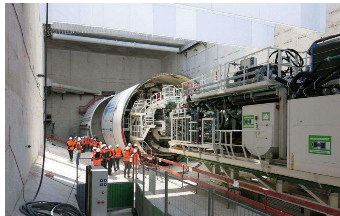
Figure 82 – Inauguration du tunnelier Magaly, qui a creusé la première partie du prolongement nord de la Ligne 14 entre Saint-Lazare et Mairie de Saint-Ouen (Source : Le Parisien)
