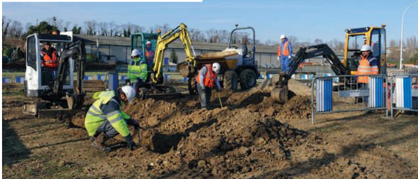
4 FÉVRIER 2015, PARCOURS D'ADAPTATION AU MÉTIER DE CANALISATEUR MINI-PELLEUR SUR L'AIRE DE FORMATION SITUÉE À NEUILLY-SUR-MARNE
