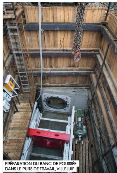
PRÉPARATION DU BANC DE POUSSÉE DANS LE Puits DE TRAVAIL, VILLEJUIF
