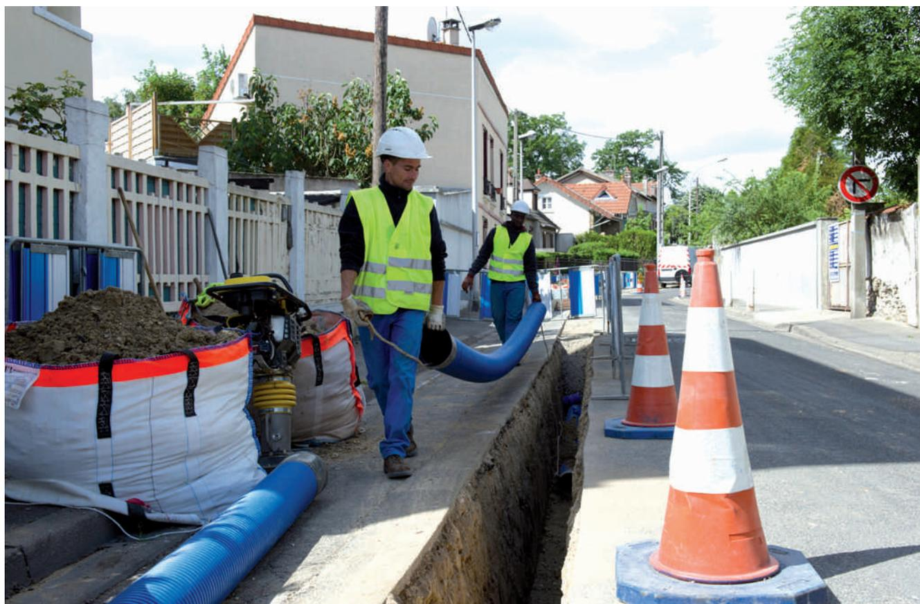
*Pose de fourreau dans le cadre de travaux de renouvellement de canalisations de distribution*
