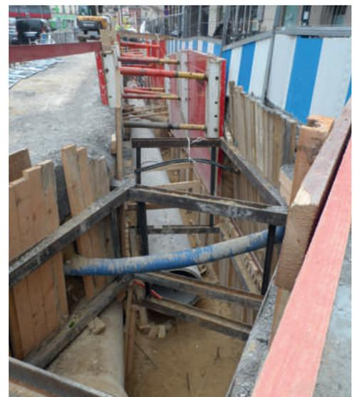
*Pose en tranchée ouverte de la canalisation de 1 000 mm de diamètre, en béton armé à âme en tôle et joints soudés*
