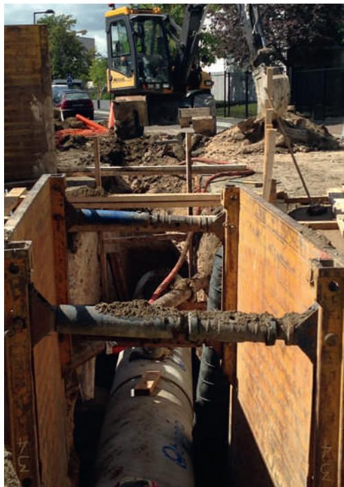
*Terrassements, blindage et pose en tranchée ouverte des tuyaux en béton armé à âme en tôle : une fois posés, les tuyaux sont soudés les uns aux autres*
