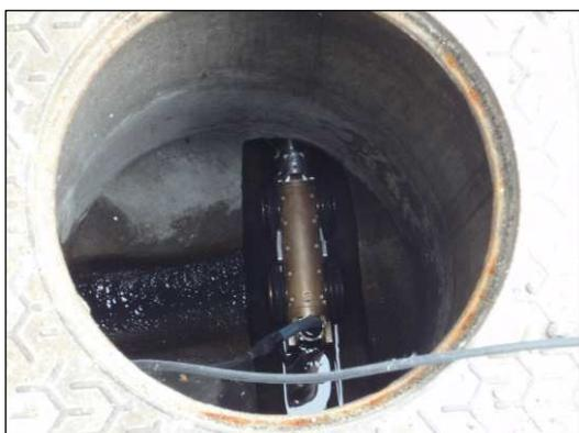
Inspection télé d'une canalisation à l'aide d'un robot
