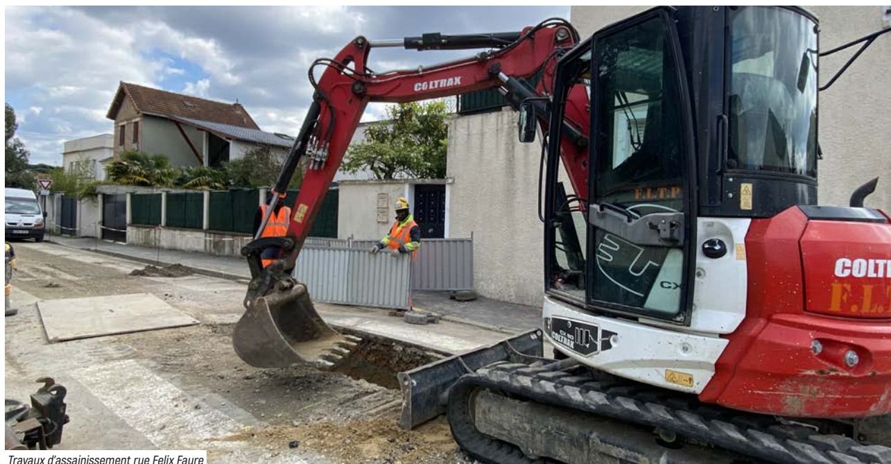
Travaux d'assainissement rue Felix Faure
