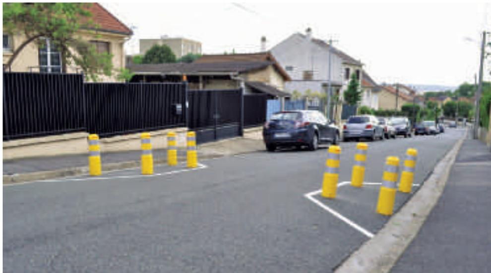
Mi-septembre - Mise en place d'un système de rétrécissement de chaussée pour ralentir la circulation, rue des Cahouettes
