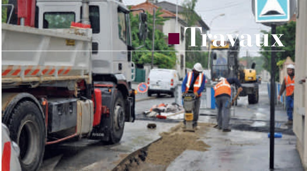
Fin juin : Fin des travaux rue Georges Clemenceau, remplacement d'une canalisation d'eau potable.
